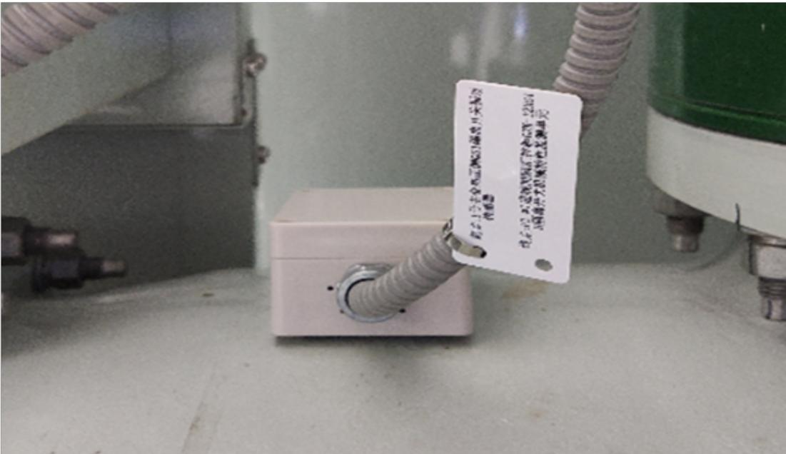
**GIS及敞开式的隔离开关监测：**技术背景隔离开关是电力系统中的重要组成部分，主要用于隔离电源、承载和切断电流电路，与接地开关共同实现对高压输电线路和电气设备的控制、保护和检修。在合闸位置时，隔离开关可承载线路额定电流及在规定时间内异常电流；在分闸位置时，隔离开关的触头间有符合要求的绝缘距离和明显的断开标志，确保检修时人员和设备的安全。然而由于在材料、工艺、设计、安装等方面存在的问题，以及频繁动作时产生的电气老化、机械磨损等缺陷，GIS及敞开式的隔离开关的故障率不断升高，严重影响隔离开关和整个电力系统的安全稳定运行。因此，在线监测隔离开关以实现故障前预警，对提高设备和电网的可靠性具有重要意义。基于实时监控隔离开关振动声学指纹及驱动电机电流信号，结合智能分析软件，实现隔离开关运行状态的\*\*\*评价，可有效确保隔离开关及电网的安全稳定运行。什么是振动监测产品图片
